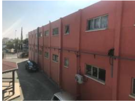
Εικόνα 4. Τυποποίηση στις όψεις των τυπικών σχολικών κτιρίων αποτέλεσμα της προσήλωσης του σχεδιασμού στον κατασκευαστικό κάρναβο.
